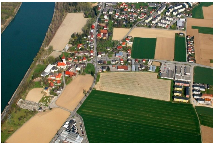
Abbildung 26: Luftaufnahme St. Florian am Inn
